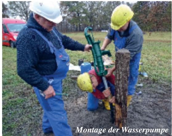
*Montage der Wasserpumpe*
